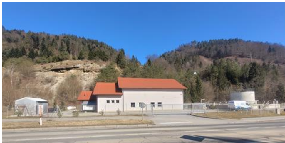
Slika: Centralna čistilna naprava v Radljah ob Dravi
