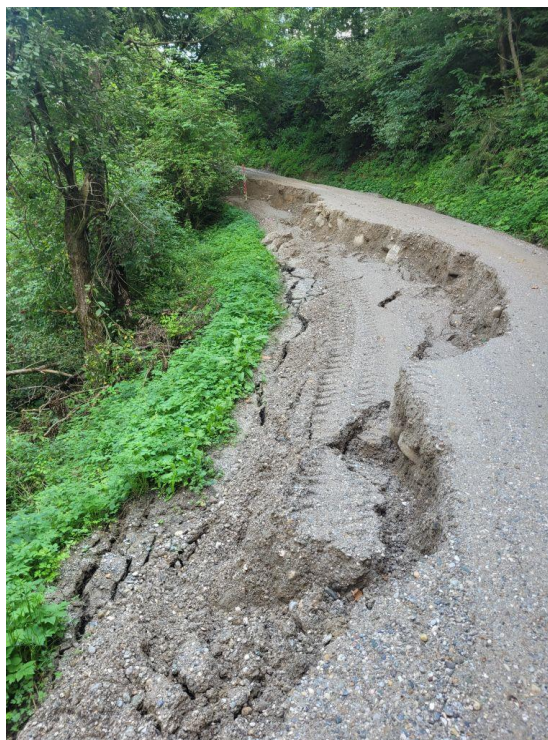
Slika 4: Lokalna cesta LC 347091
