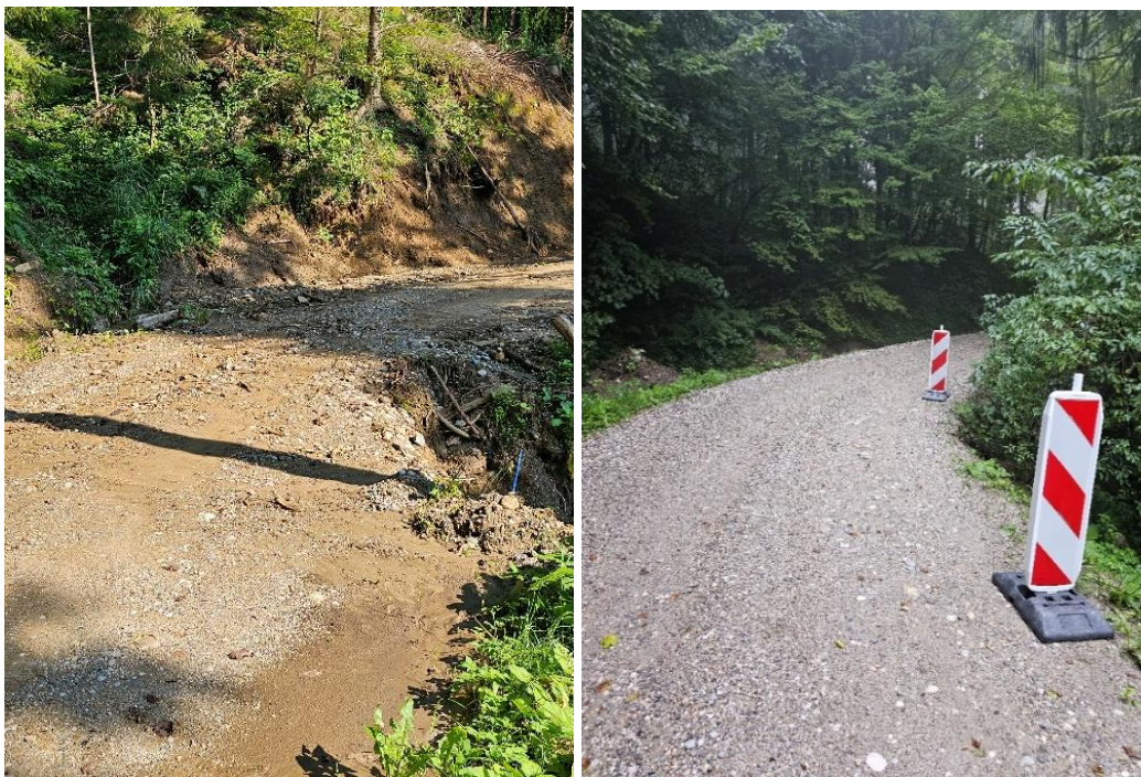
Slika 4: Lokalna cesta LC 347101
