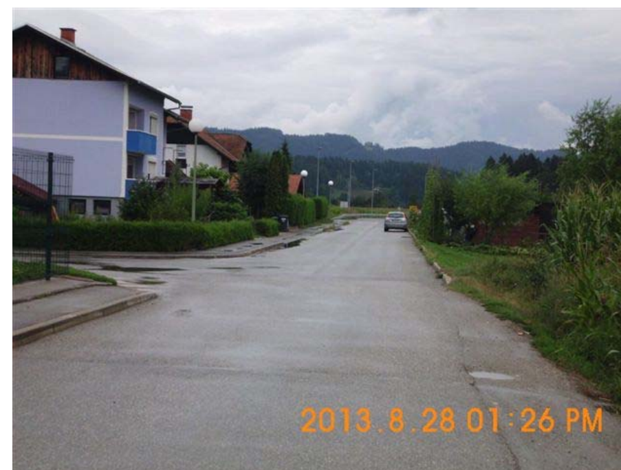
Slika 157: Priključevanje Mariborske c. na Obrtniško ul. (pri podjetju Frido)
