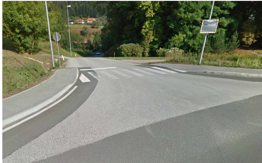
Slika 150: Križišče Koroške c.: predlagamo, da se pločnik za pešce izvede ob levi strani vozišča (nadaljevanje obstoječega)
