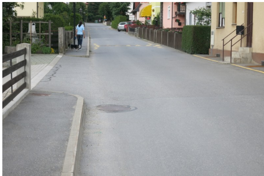
Slika 111: Manjkajoči prehod za pešce na mestu priključka
