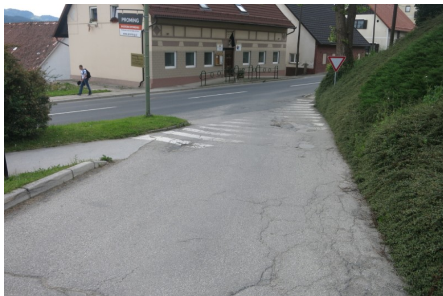
Slika 103: Razpokano vozišče z udarnimi jamami
