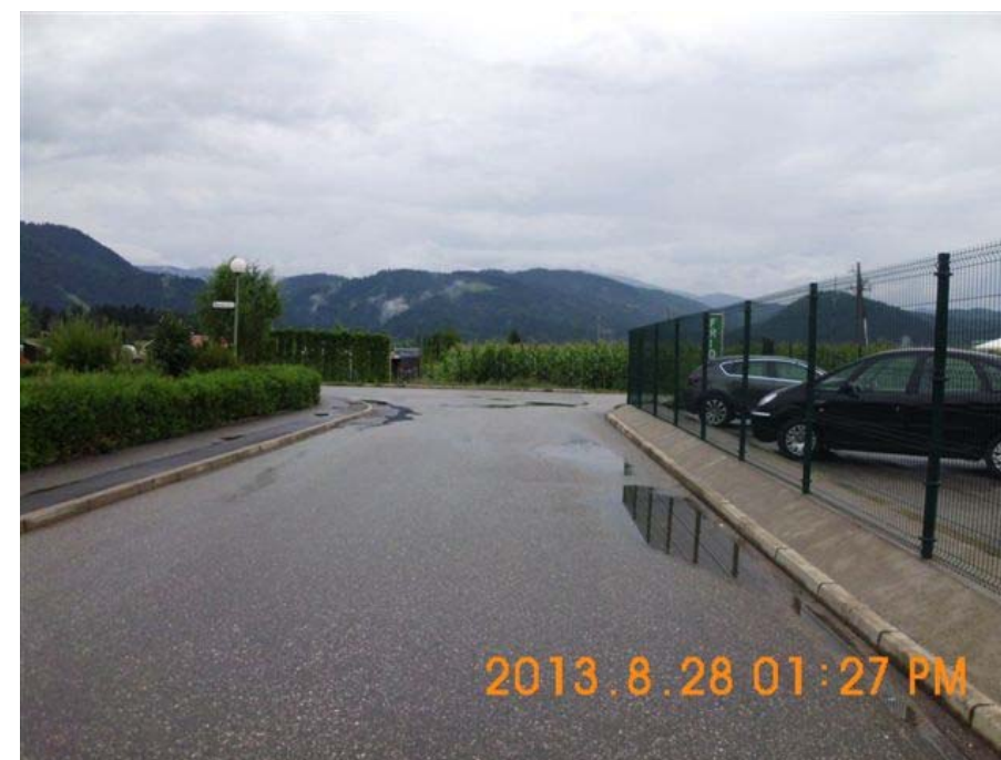
Slika 156: Priključevanje Mariborske c. na Obrtniško ul. (pri podjetju Frido)
