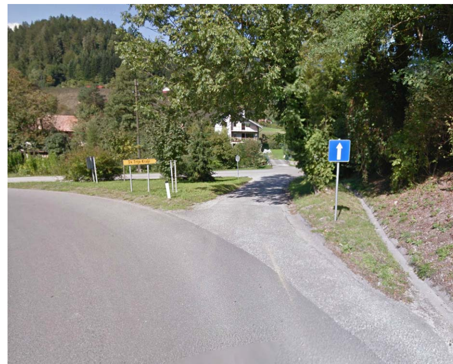
Slika 148: Križišče Koroške c. in Samostanske ul.: ureditev pločnika ob desnem robu vozišča
