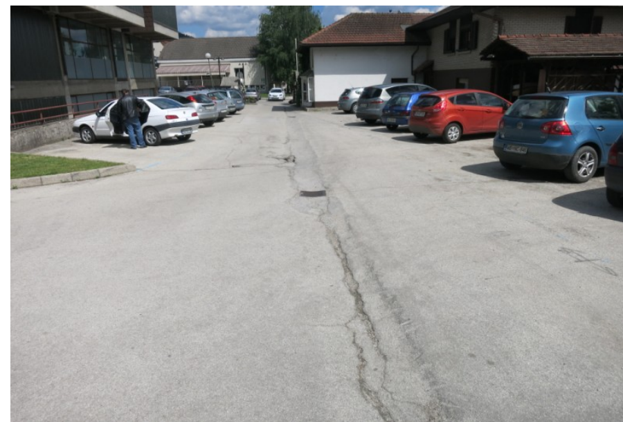
Slika 104: Poškodovano vozišče na mestu izvedenega odvodnjavanja (mulda)
