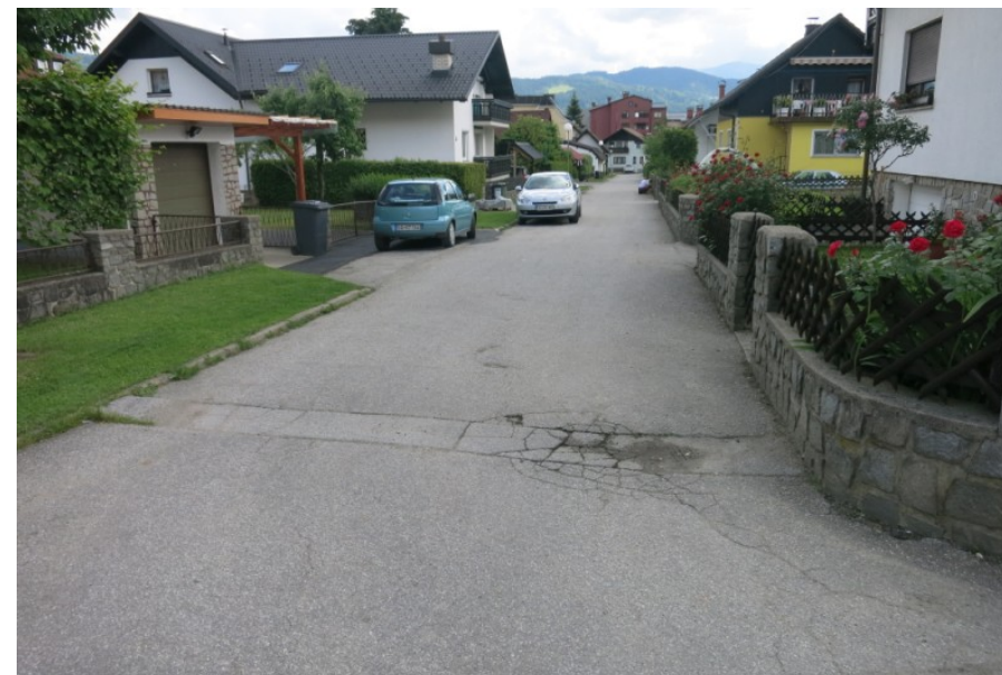
Slika 105: Poškodovano vozišče na mestu prekopa
