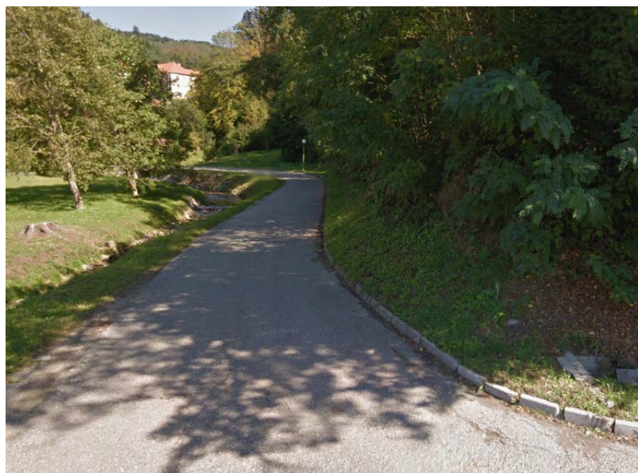
Slika 147: Samostanska ul.: ureditev pločnika ob desnem robu vozišča (robnik že položen)
