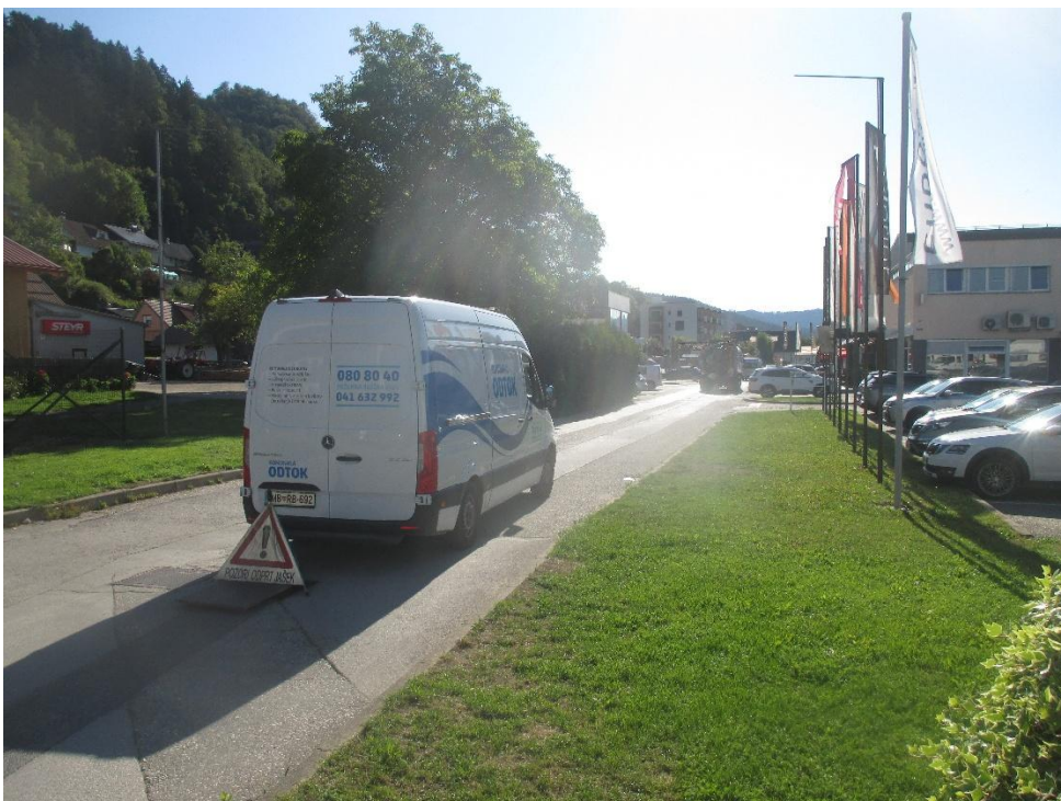
Snemanje kanalizacijskega omrežja na Koroški cesti v Radljah ob Dravi.
