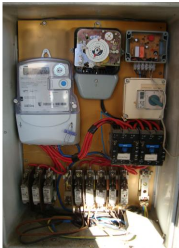
Slika 6: Primer odjemnega mesta (nov števec) Slika 7: Primer odjemnega mesta (star števec)
