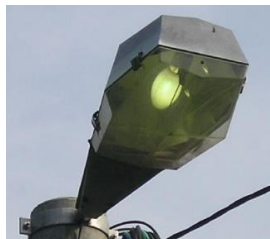
Slika 4: Primer neustrezne svetilke CD (Elektrovina)
