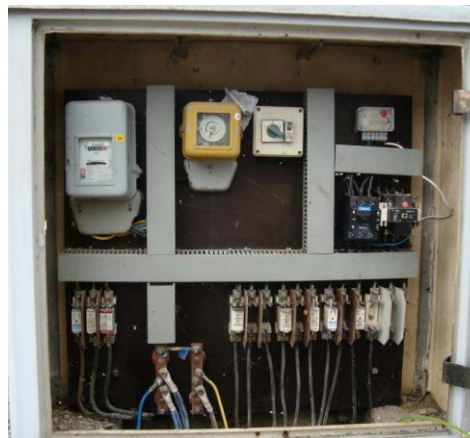
Slika 6: Primer odjemnega mesta (nov števec) Slika 7: Primer odjemnega mesta (star števec)
